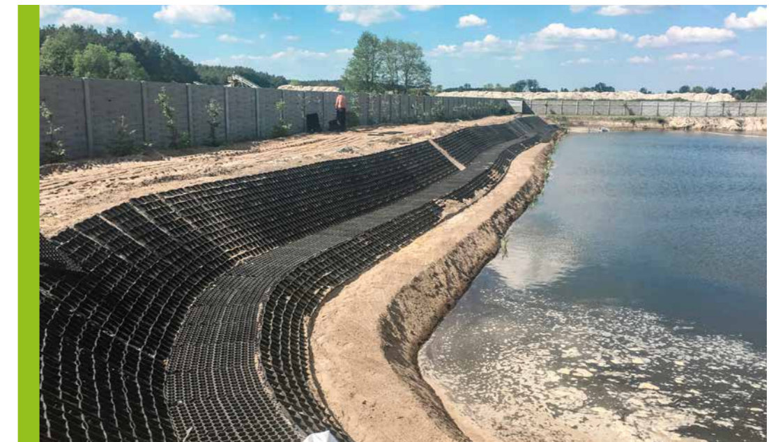
Zagospodarowanie otoczenia oraz wzmocnienie brzegów stawu, Środa Wielkopolska
