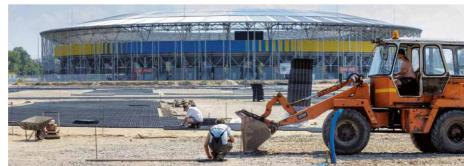
Rozprowadzenie warstwy nośnej
