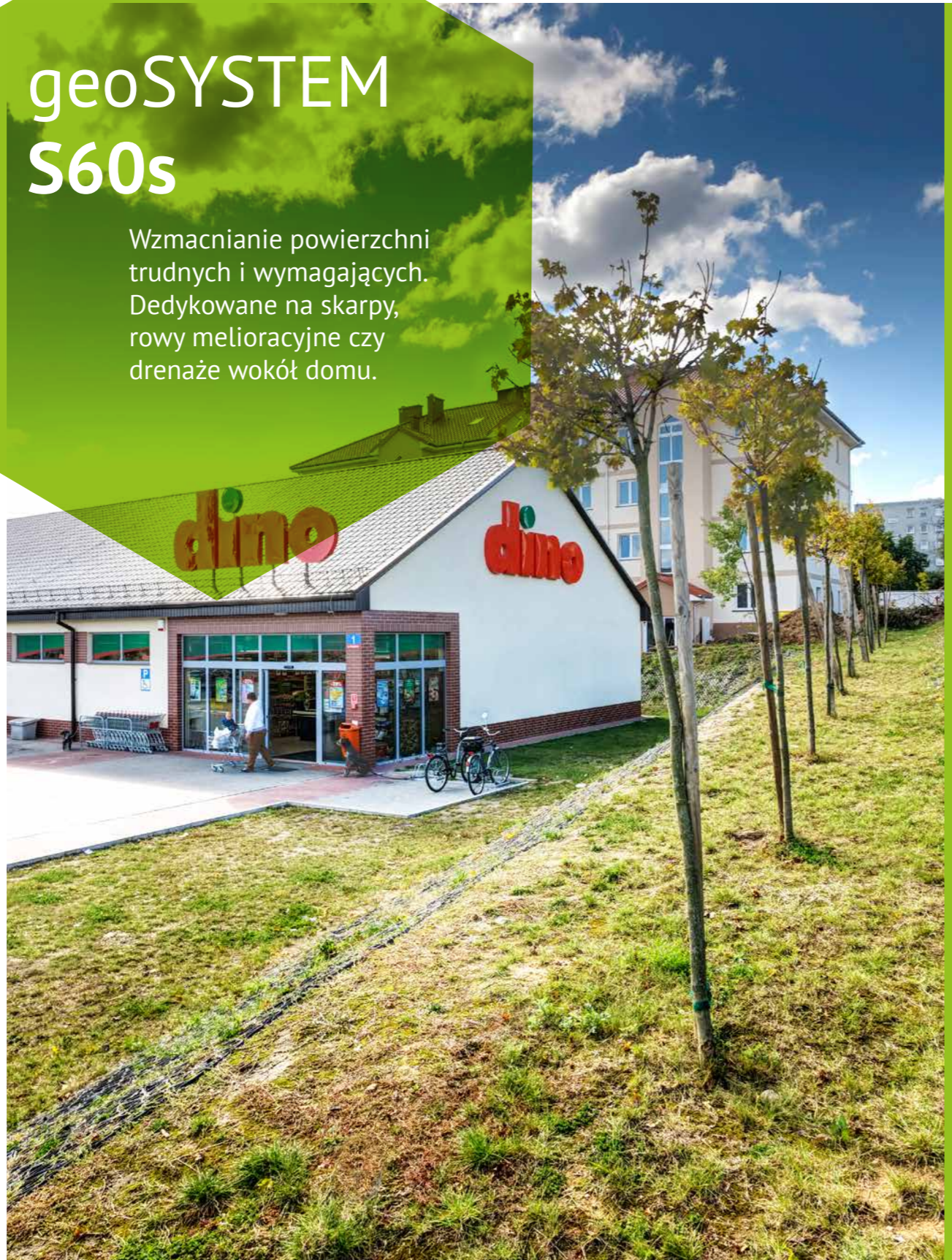
Zabezpieczenie pochyłego terenu przed marketem Dino, Świebodzin
