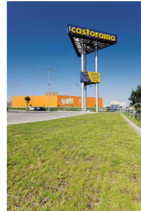
Tymczasowe miejsca postojowe, Centrum Handlowe Castorama, Lubin
