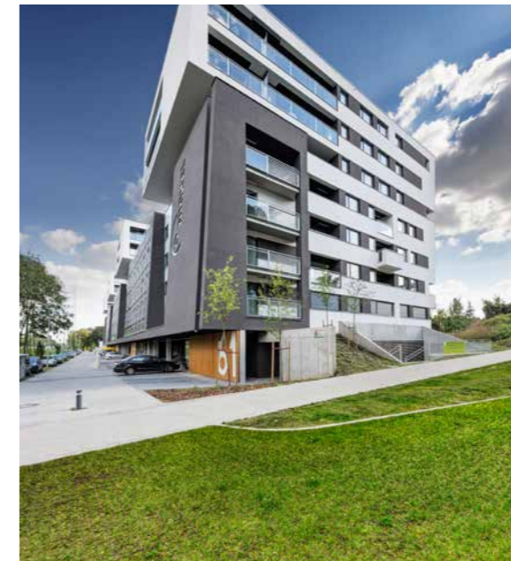
Droga pożarowa, osiedle Nikiel, Poznań
