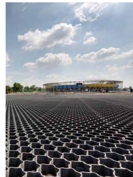
Nawierzchnia przygotowana do wypełnienia ziemią i zasiania trawy, Toruń
