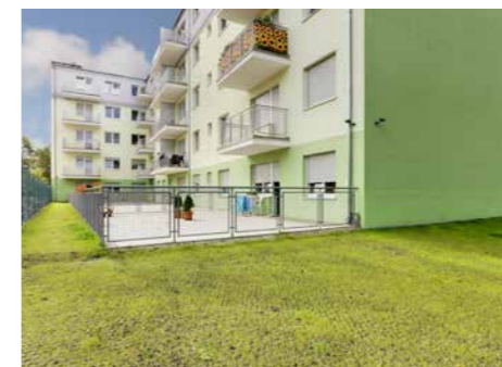
Zielona droga pożarowa na osiedlu, Poznań
