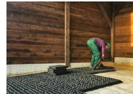
Montaż nawierzchni HD5
