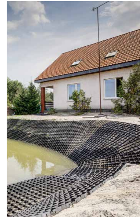
Wzmacnienie brzegów stawu, Grójec
