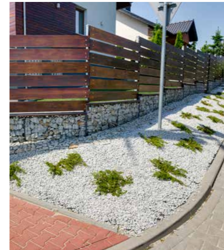
Opaska wokół płotu wypełniona kruszywem, Suchy Las
