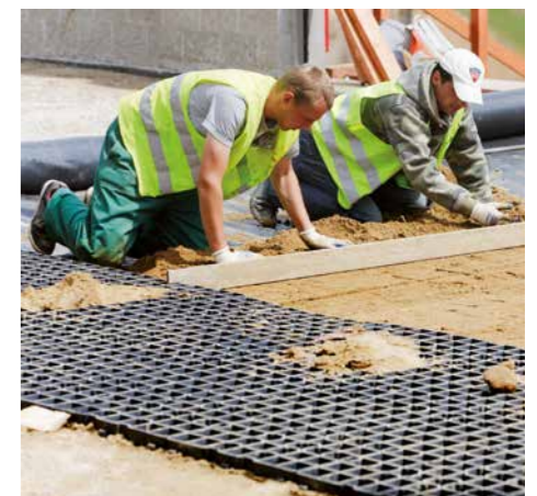
Rozprowadzenie warstwy wyrównującej
